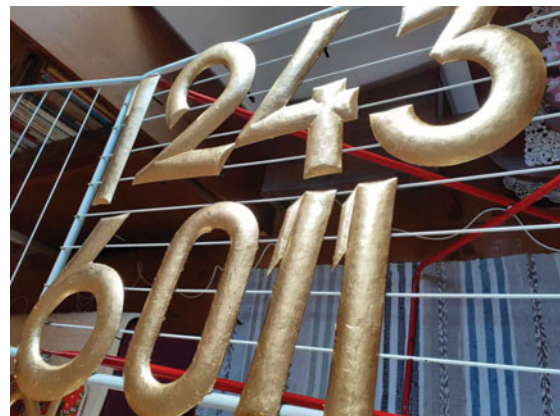
REKONŠTRUOVANÉ PODLAŽIE S CIFERNÍKMI A PREVODOVÝM MECHANIZMOM. ČÍSLICE HODINOVÝCH CIFERNÍKOV – SUŠIACE SA PO ICH ZLÁTENÍ.
