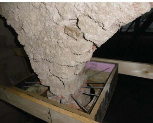
PRÁCE NA OKENNÝCH STĹPOCH, REALIZOVANÉ SPOLU S VYSTUŽENÍM ICH NOSNEJ ČASTI.
